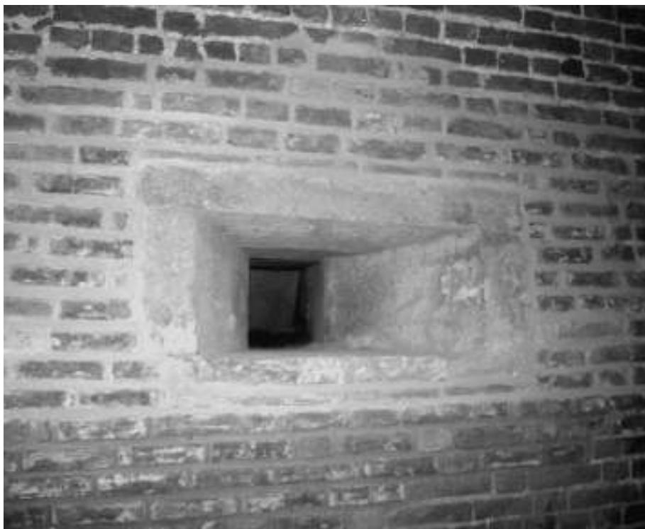
Fig. 16 - La bocca interna di una delle due cannoniere tipo C che si aprono sulle sale interne della prima corte. Come si vede, protrae la pianta "a clessidra" delle forme iniziali dell'inizio del Cinquecento, anche se lo strombo interno è appena accennato e le dimensioni assolute sono aumentate.
