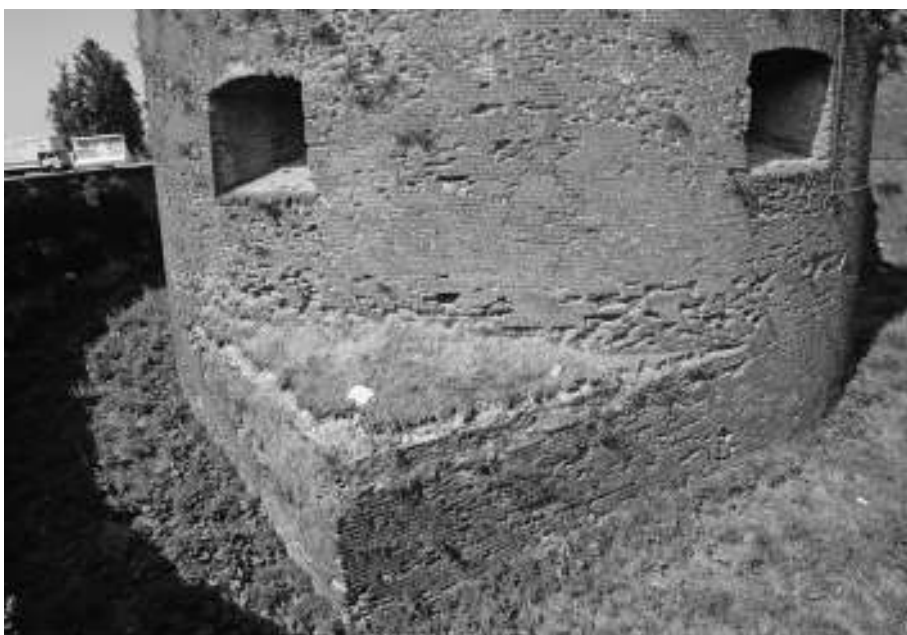
Fig. 24 - Alla base dei torrioni francesi è posto un ostacolo passivo triangolare ad impedire che eventuali assalitori si riparassero dal tiro fiancheggiante nell'angolo morto dei torrioni a pianta circolare. Anche questo è curiosamente un elemento ripreso da castelli medievali come Monte Battagli di Casola Valsenio (RA), Caerphilly (Galles) o Beaufort-en-Vallée (Maine-et-Loire, F).
