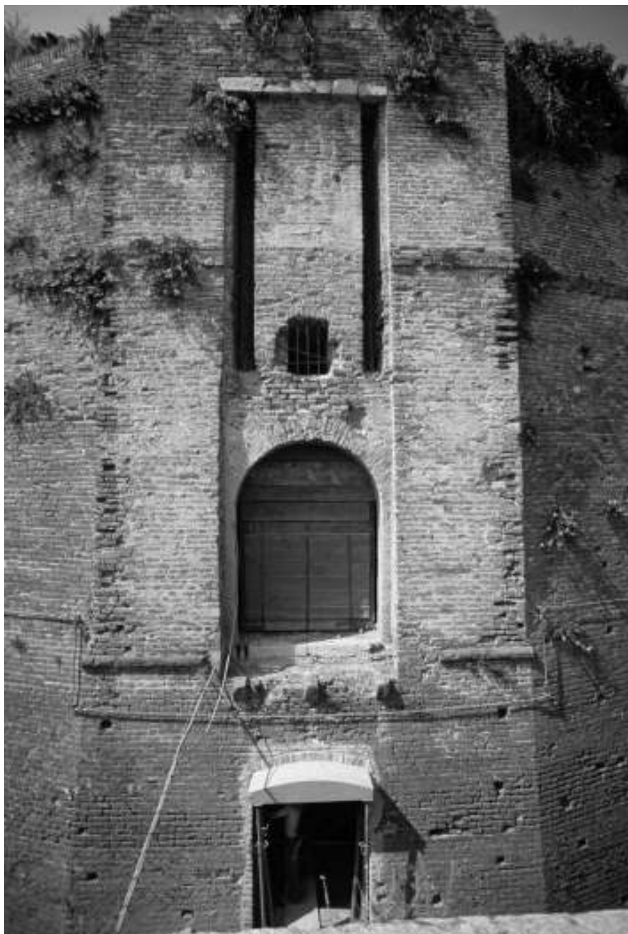
Fig. 21 - Le porte della fortezza sono poste in corpi di modestissimo aggetto planimetrico i cui ponti levatoi sono a bolzoni contrappesati; sotto l'ingresso principale le mensole reggiponte in pietra contribuiscono ad accentuare l'aspetto arcaico della porta. Era quindi sorta l'ipotesi che si trattasse di più antichi rivellini rettangolari inglobati nelle cortine angolate dei lati maggiori. In basso i resti delle porte che verosimilmente consentivano le comunicazioni con le lunette esterne.
