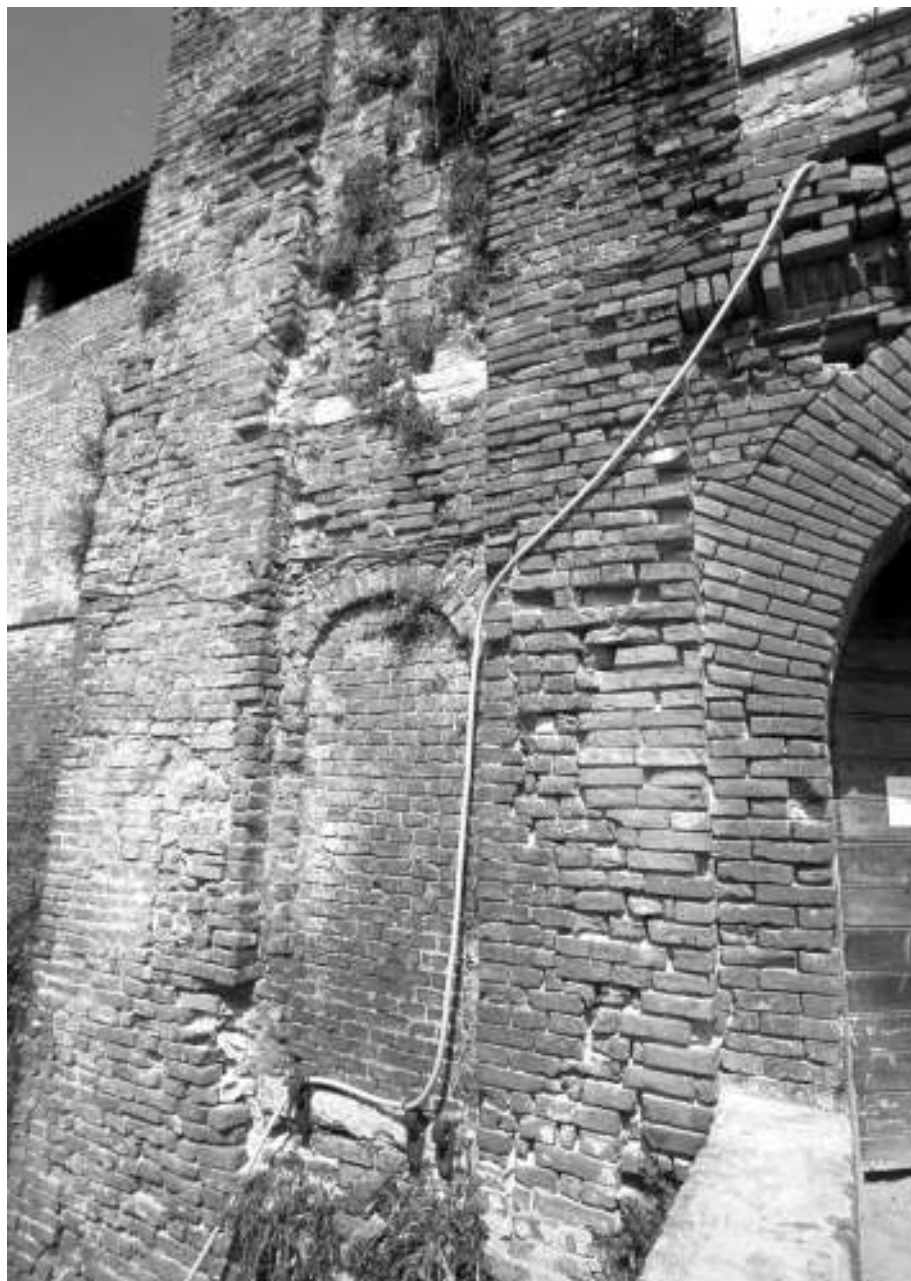
Fig. 22 - Nella porta pedonale dell'ingresso nord si trovano ancora le cerniere in ferro del pontile. Nel vano sotterraneo della porta vi sono indizi che l'ingresso fosse provvisto di un ancora più incongruo pontile a travi principali prolungati e contrappesati, ma potrebbe trattarsi dei resti del ponte levatoio della porta inferiore.
