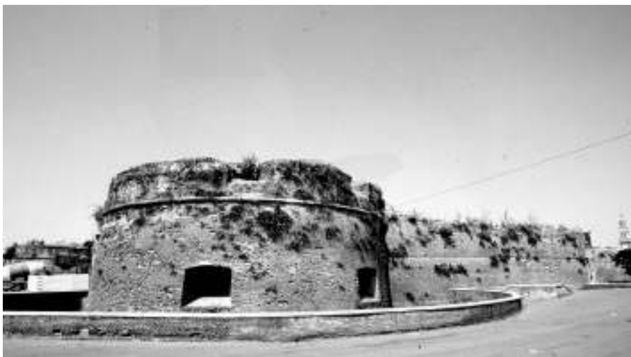
Fig. 23 - Il torrione nord-ovest, come quello nord-est, fu ricostruito dai francesi all'inizio del Settecento e presenta cannoniere tipo F nonché, in sommità, un coronamento a merloni e troniere. E' quasi troncoconico perché la cordonatura non separa la scarpa da un paramento nettamente verticale come negli ingressi e nei lati minori.
