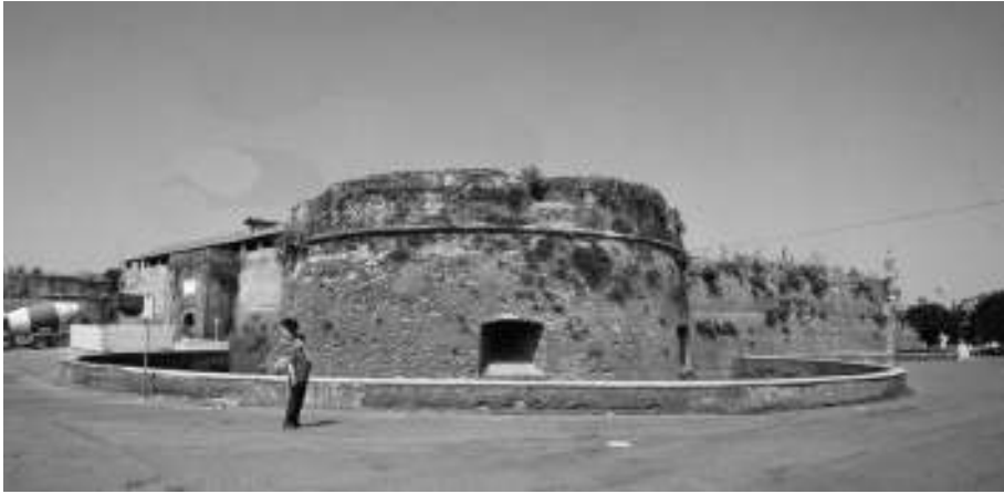
Fig. 1 - La fortezza di Casale si presenta coi rapporti plani-altimetrici della fortificazione bastionata, pur conservando gli elementi angolari a pianta circolare. Notare, a sinistra, la torre portaia ancora prominente in pianta rispetto alla cortina, mentre sul lato di città il rifasciamento ha portato ad una cortina rettilinea.
