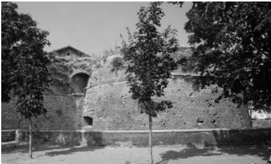
Fig. 14 - Gli elementi cilindrici angolari che forniscono il vitale tiro fiancheggiante hanno rapporti dimensionali intermedi fra i torrioni e le rondelle, fra quelli di Milano ed Imola e quelli di Padova e Treviso, per fare un esempio, e almeno dalla quarta fase in poi erano coronati "alla francese", con i profondi merloni tipici della fortificazione bastionata introdotti nei primi anni del Cinquecento.
